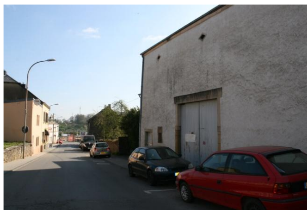
Vue sur le tissu bâti adjacent
