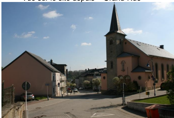
Vue sur le tissu bâti adjacent
