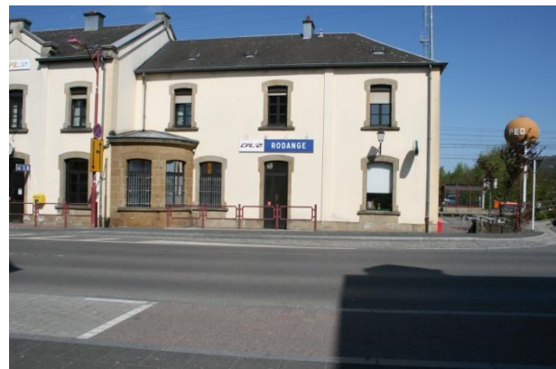
Vue sur la gare de Rodange à proximité directe
