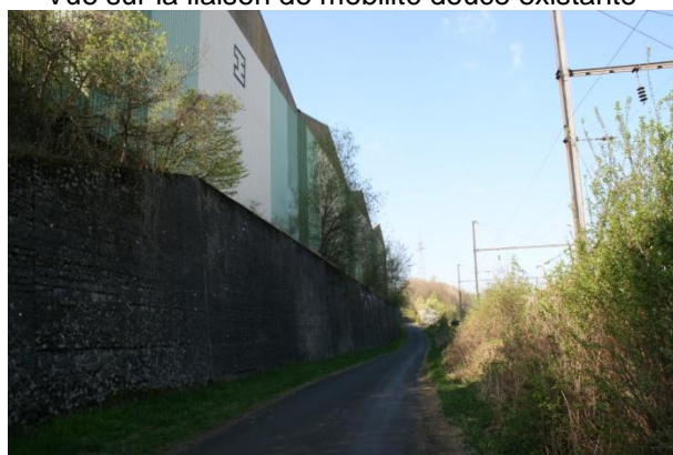
Vue sur le mur de soutènement
