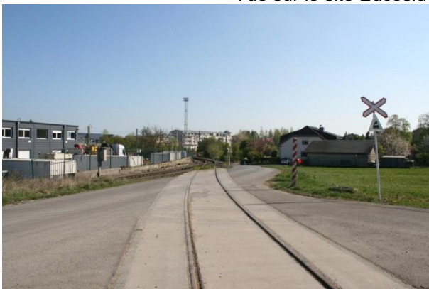
Vue sur le tracé du train 1900
